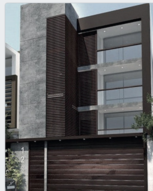
Edificio Covima Ate
