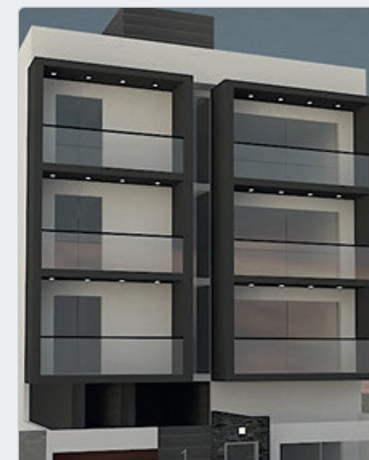
Edificio Gonzales Huampaní
